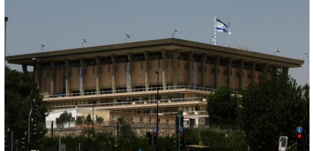
Vue générale du bâtiment de la Knesset
